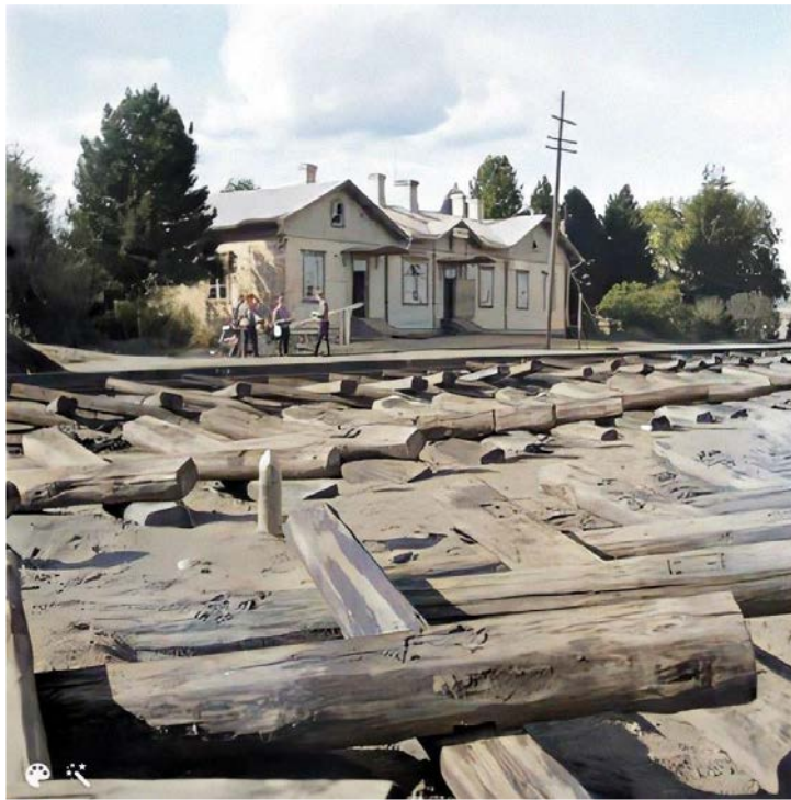
Kuva 29. Inkilän asema sodan jälkeen (SA-Kuvat).
