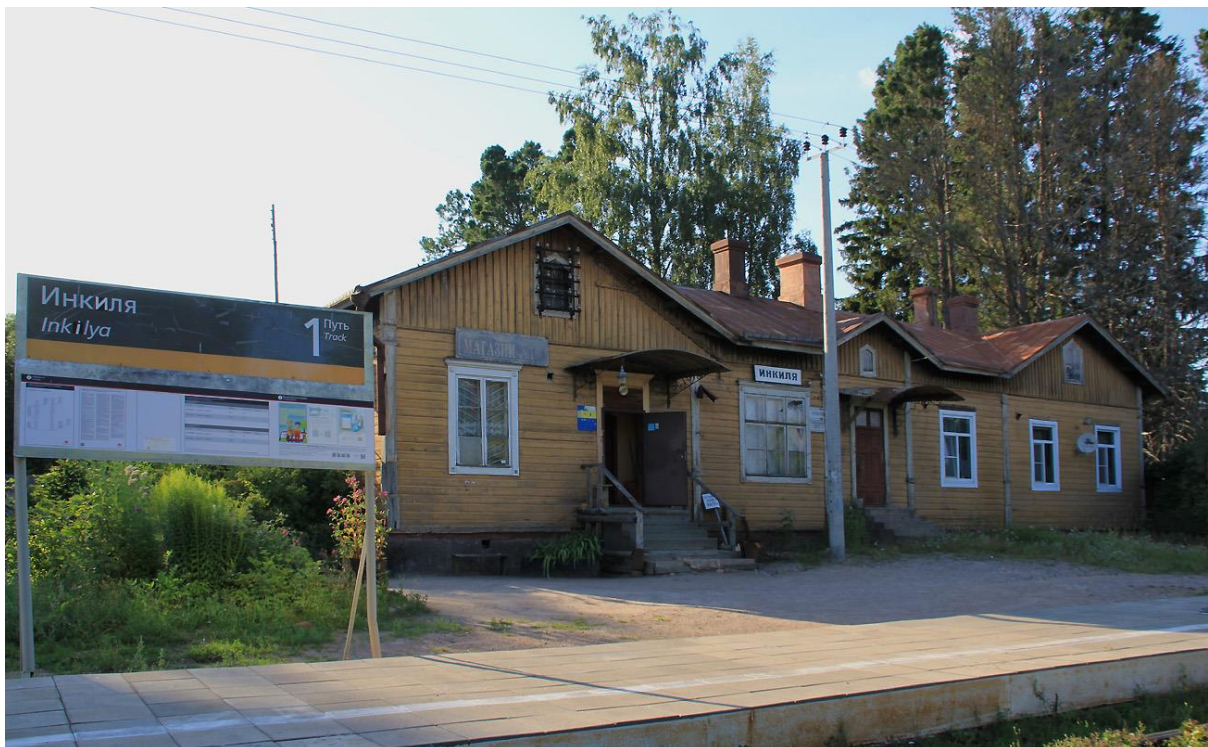
Kuva 30. Inkilän asema vuonna 2019. Osa ikkunoista uusittu. ( J. Pyytövaara, Vaunut.org)
